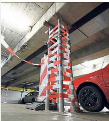
Vor zwei Monaten hat die Stadt als Vorsichtsmaßnahme Metallstützen im Parkhaus einbauen lassen. Bild: Dinkels
