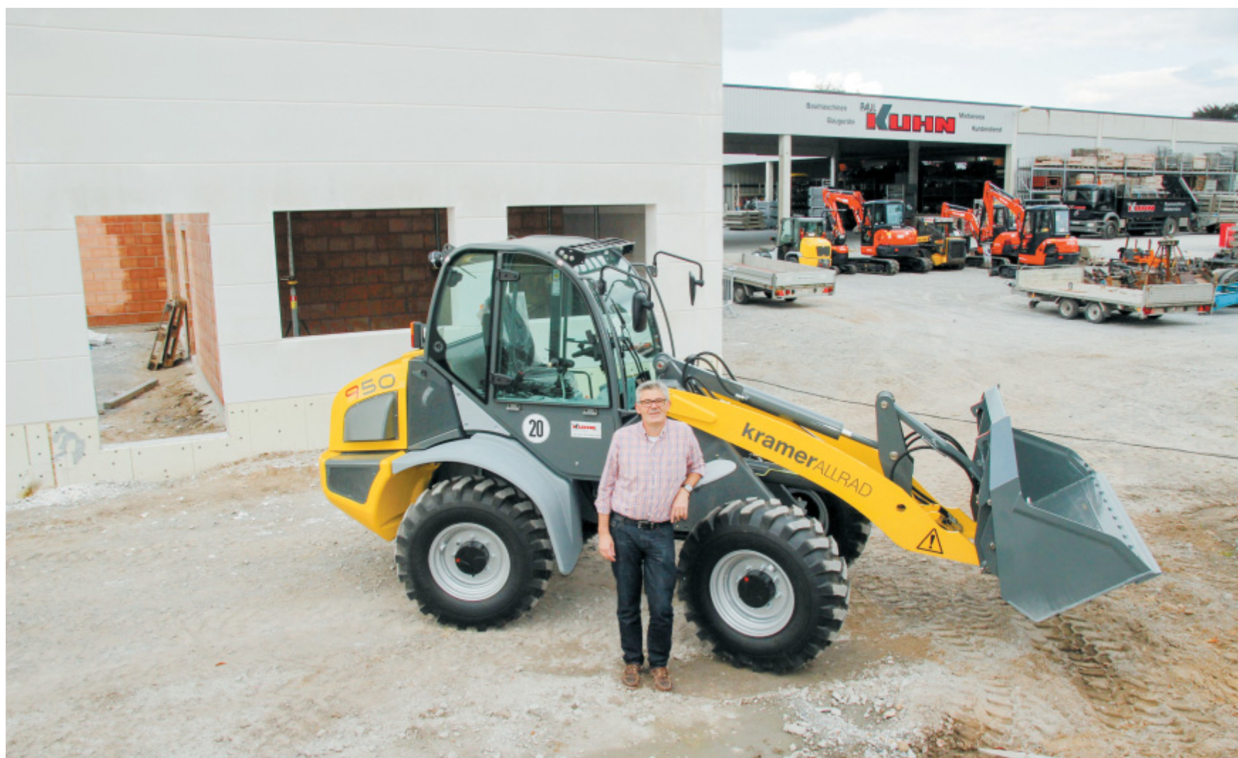
Mehr Platz für die Werkstatt: Burkhard Kuhn baut seinen Betrieb am Leinenweg aus. Rund 600.000 Euro investiert der Unternehmer in die neue Halle..
